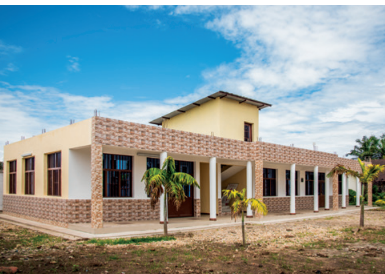
Der neue Anbau der Bildungsakademie in Burundi.
